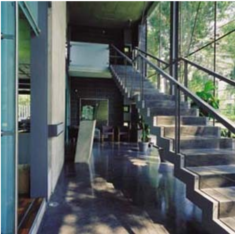
-Látszóbeton a közlekedő és a lépcső felületén
